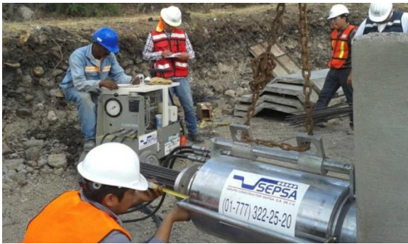
Servicio de Postensado.
