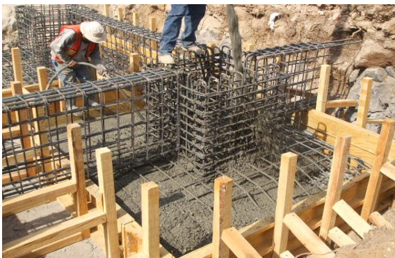
Servicio de Obra Civil.
