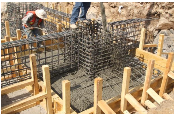
Servicio de Obra Civil.
